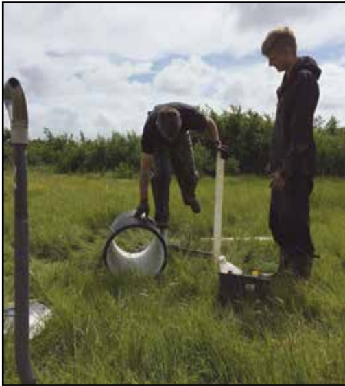
En udvidet pejlestation med dybt og kort rør bliver etableret. Som fakta-boksen foreskriver kan rørene etableres ved brug af kropsvægt. Foto: WatsonC.
