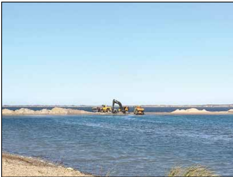
Maskinerne er ved at fjerne forbindelsen fra fastland til øen.
